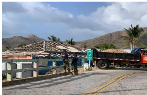
Registro fotográfico descarga de escombros para el relleno
