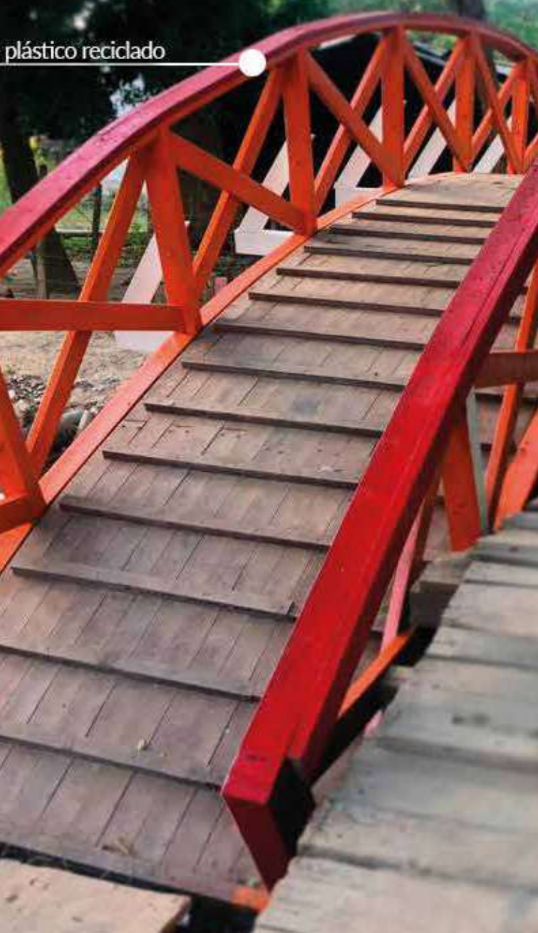
PUENTE DE POLICARPA. FOTOGRAFÍA: ESENTIA
