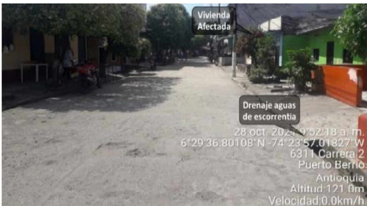
Figura 7. Vista de la vía principal de la vivienda, donde se observa un punto de drenaje pluvial. 23
