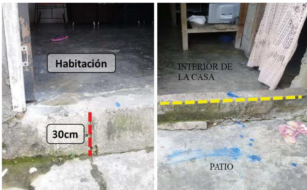
Figura 3. Habitación está construida sobre un piso elevado y el muro que existe entre el patio y el interior de la vivienda. 21
