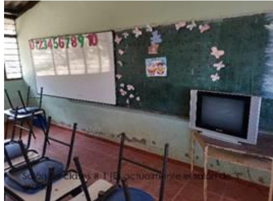
Fotografía No. 5. Salón de Clase #1 (Usado como aula de 3°)
